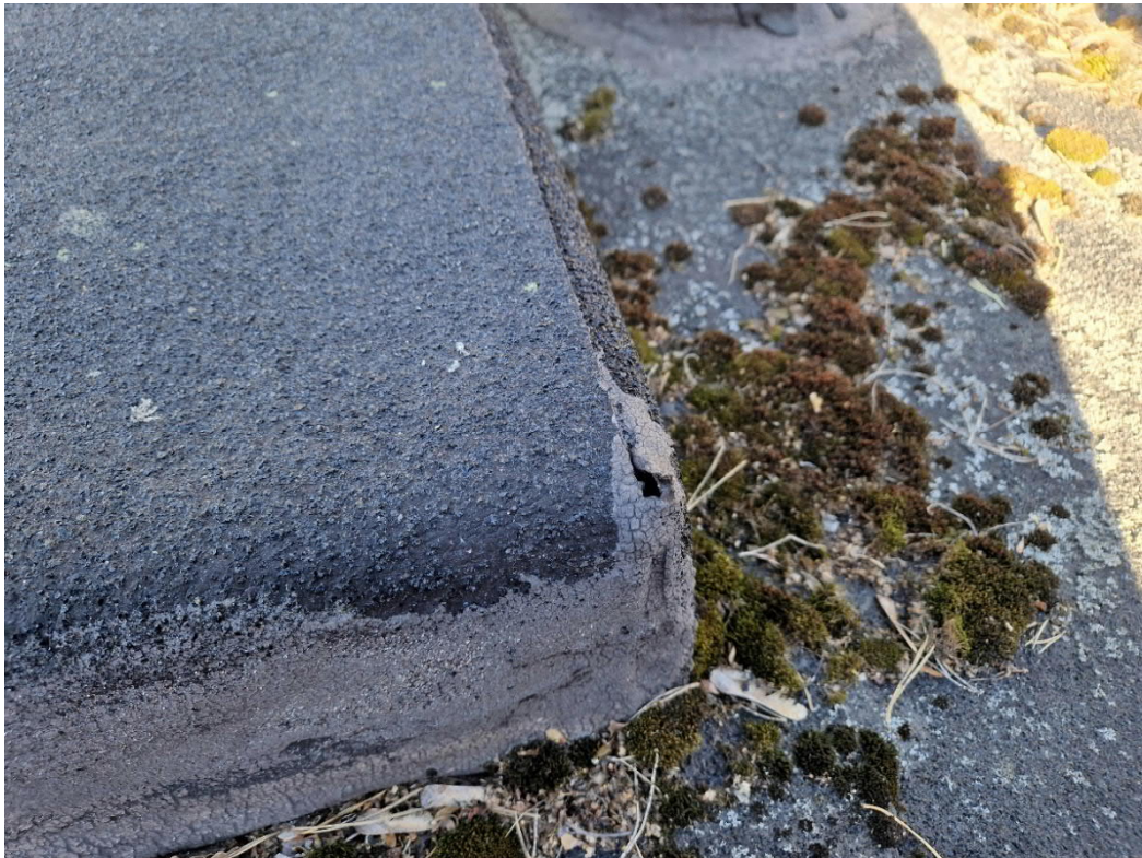
Kuva 16. Huopakatteen pinnassa on havaittavissa runsaasti sammal- ja jäkäläkasvustoja.
