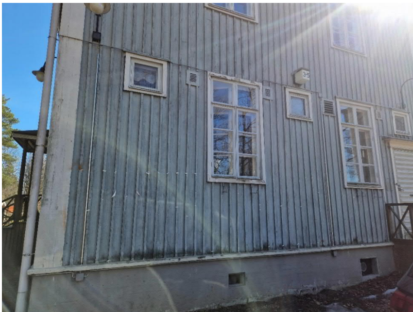
Kuva 20. Raitisilmaventtiilit ulkoseinässä.
