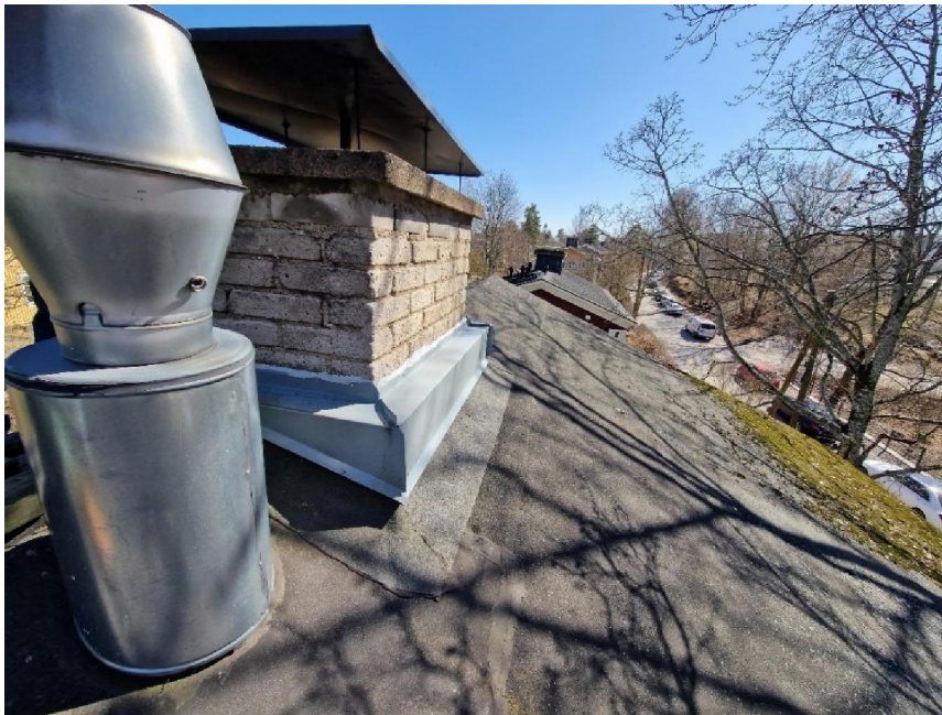
Kuva 19. Poistoilmapuhallin vesikatolla.
