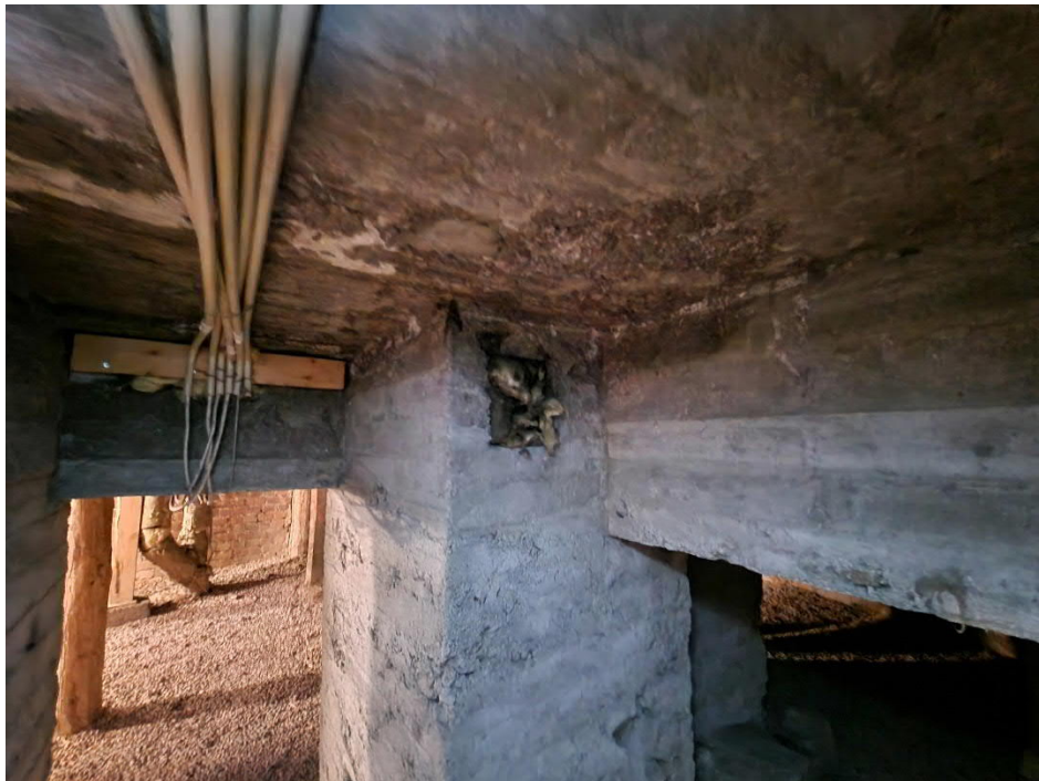
Kuva 4. Yleiskuva kellaritilasta. Kellaritilan sisäilmassa ei havaittu tutkimusten aikaan poikkeavaa hajua. Kellaritila oli pääsääntöisesti kuiva ja tuulettuva.
