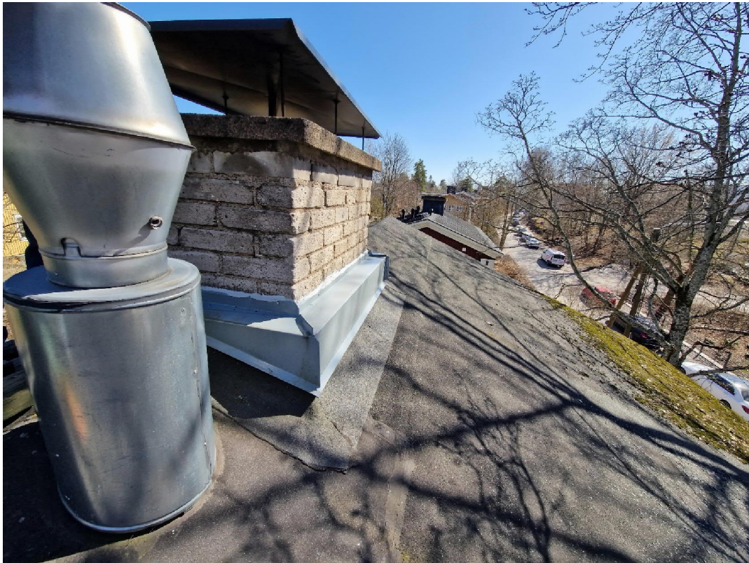
Kuva 14. Savupiipun juureen on lisätty pellitys ja pellitystä tiivistetty.
