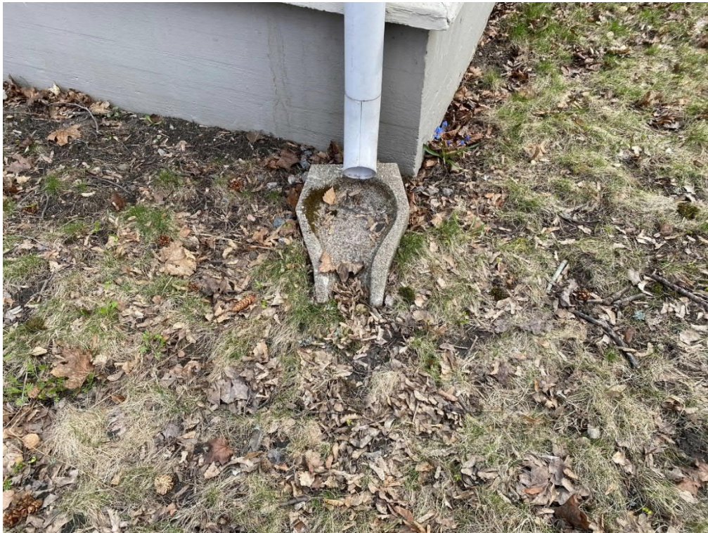
Kuva 2. Vesikattojen sadevedet ohjautuvat rakennuksen vierustaän.
