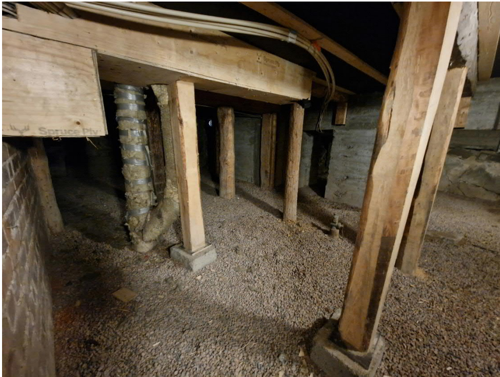
Kuva 6. Kantavia puurakenteita uusittu edellisen korjauksen yhteydessä. Rakenteissa ei havaittu vaurioita.
